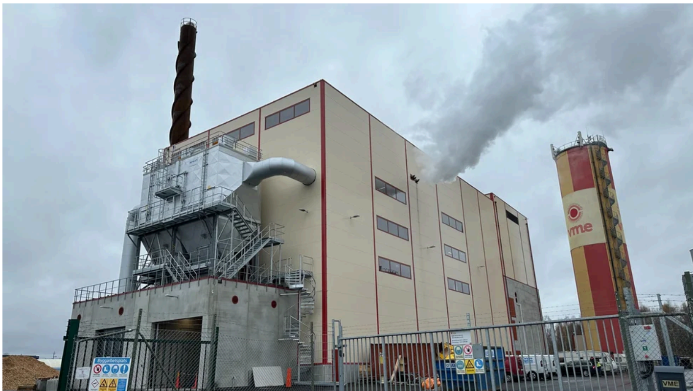
Nya flispannan med rökgasreningen utanpå byggnaden. Bild: Fredrik Klevenhaus
