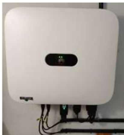
Växelriktaren till solcellerna, en låda på källarväggen.
