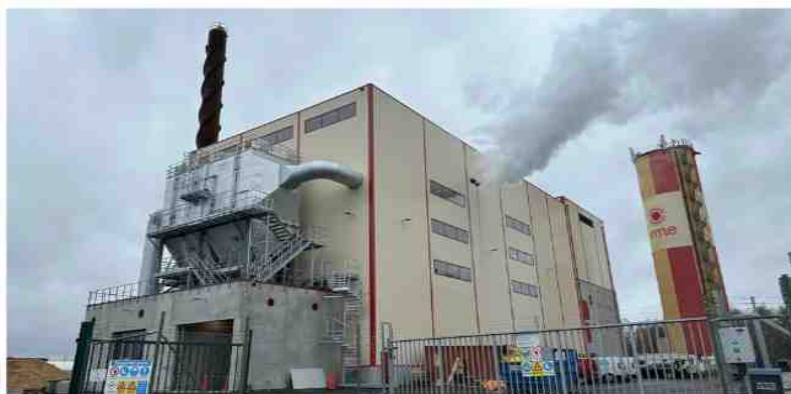
Nya flispannan med rökgasreningen utanpå byggnaden. Bild: Fredrik Klövenhaus
